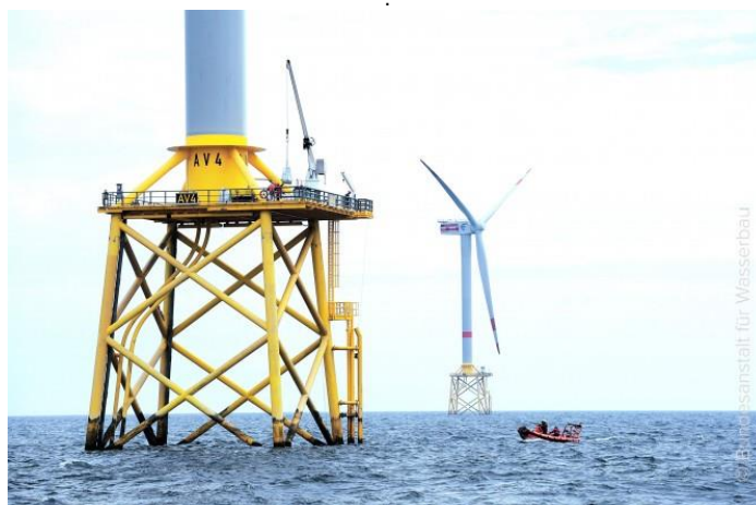
Figura 17 - Fundação fixa Jacket na Central Eólica Offshore "alpha-ventus" - © DOTI 2011 / alpha ventus, fotografia por Matthias Ibeler (Pohl, 2013).
