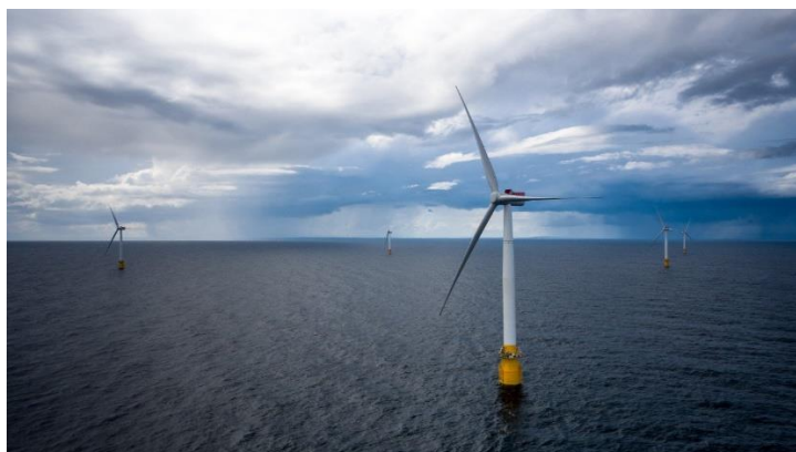
Figura 20 – Fundação Flutuante Hywind - Central Eólica Offshore Flutuante Hywind Scotland - Fotografia por Øyvind Gravås/Woldcam - Statoil ASA (Rummelhoff, 2017).
