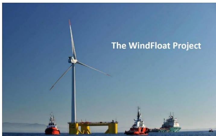
Figura 19 – Fundação flutuante WindFloat – Reboque da plataforma Windfloat na costa Portuguesa (WindPlus, 2017).
